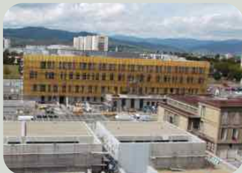
Les abords extérieurs du BMT
